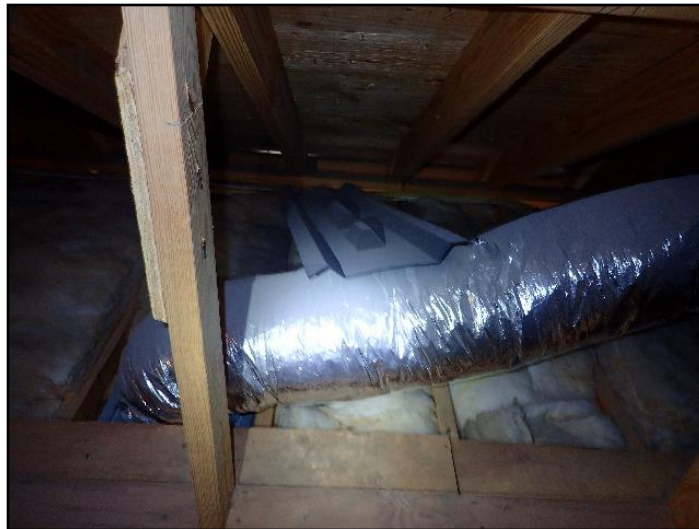
Loose soffit vent
