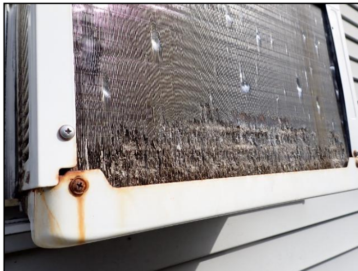
Damaged fins
